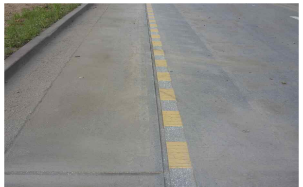
기존 노면차선위 RS-Line(도색전) 및 횡단배수홈
